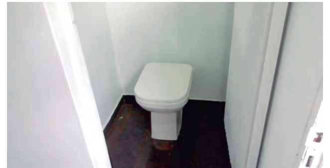
Clube de campo teve os banheiros e a cozinha reformados
